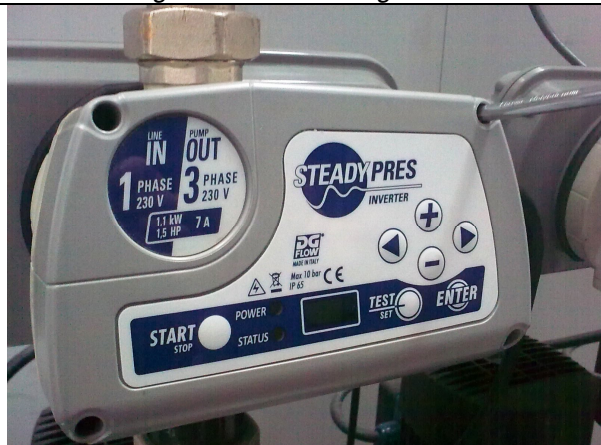
Zum Öffnen des vorderen Deckels die 4 Schrauben abschrauben.
