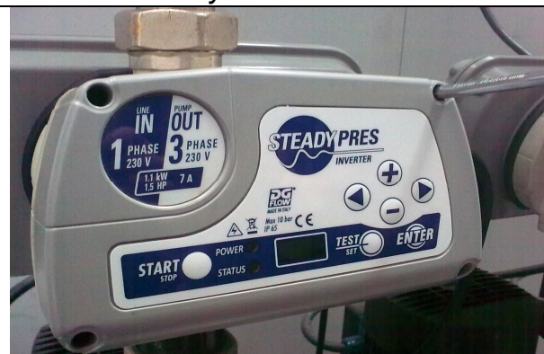
Откройте переднюю крышку, отвинтив 4 винта
